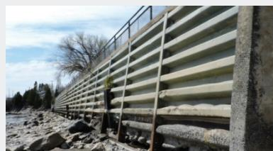
corrosion observée à sa base. Les autres sections du mur ont été construites en maçonnerie, donc moins sensibles à l'humidité et aux vagues. Une inspection sera tout de même réalisée au courant des prochains mois afin de prévenir tout problème de structure.
